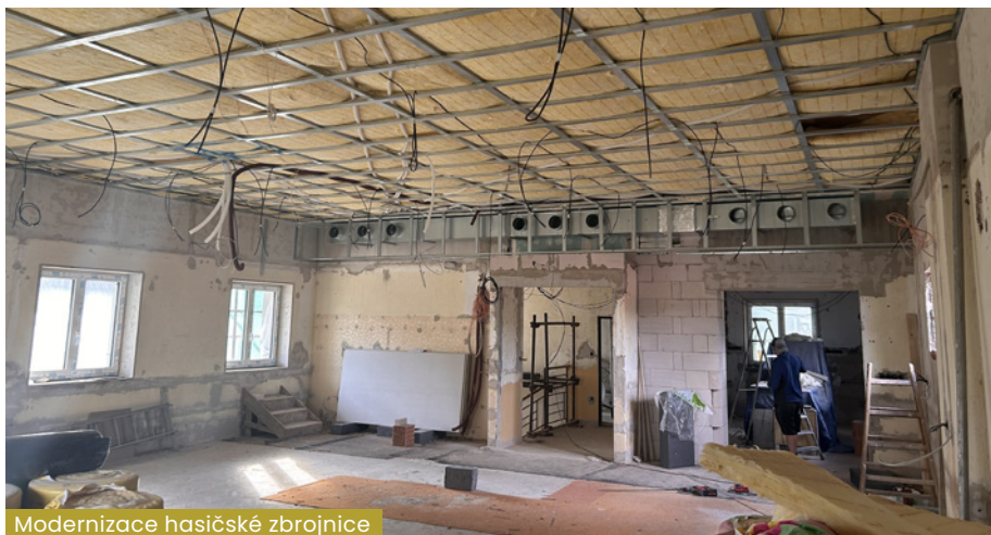
Modernizace hasičské zbrojnice
